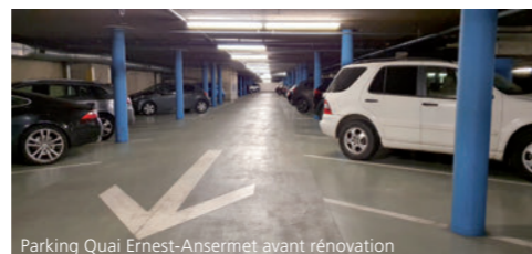
Parking Quai Ernest-Ansermet avant rénovation
